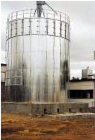
Silo 396 m 3 , Isoliert mit eingebauter Heizungsanlage
